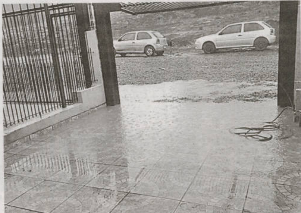
Morador reclama de alagamento causado por desnível na rua
