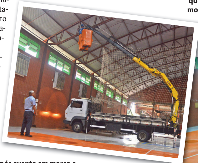
Após evento em março e reclamações de vereadores, terceirizada executa limpeza e melhorias na estrutura
