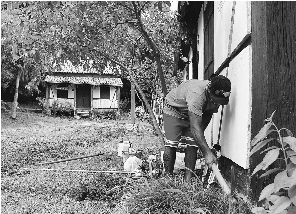
Instalação de nova rede hidráulica está entre as obras
