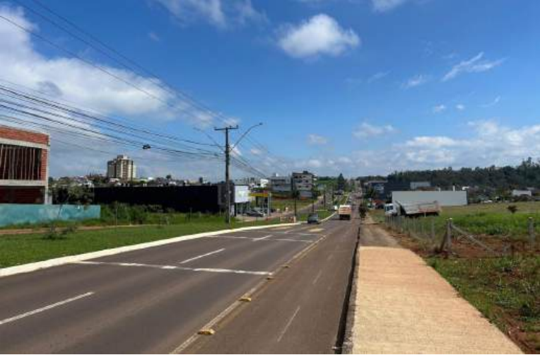
Ao todo, serão construídos 10 retornos em 5 locais distintos
