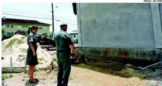
Construção do quartel foi feita graças a parceria entre comunidade e município
