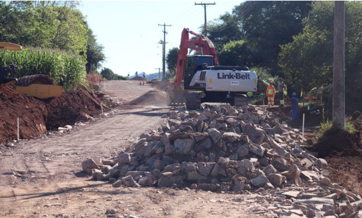
Pavimentação é o modelo mais comum da contribuição de melhoria. Outras obras também constam no projeto
