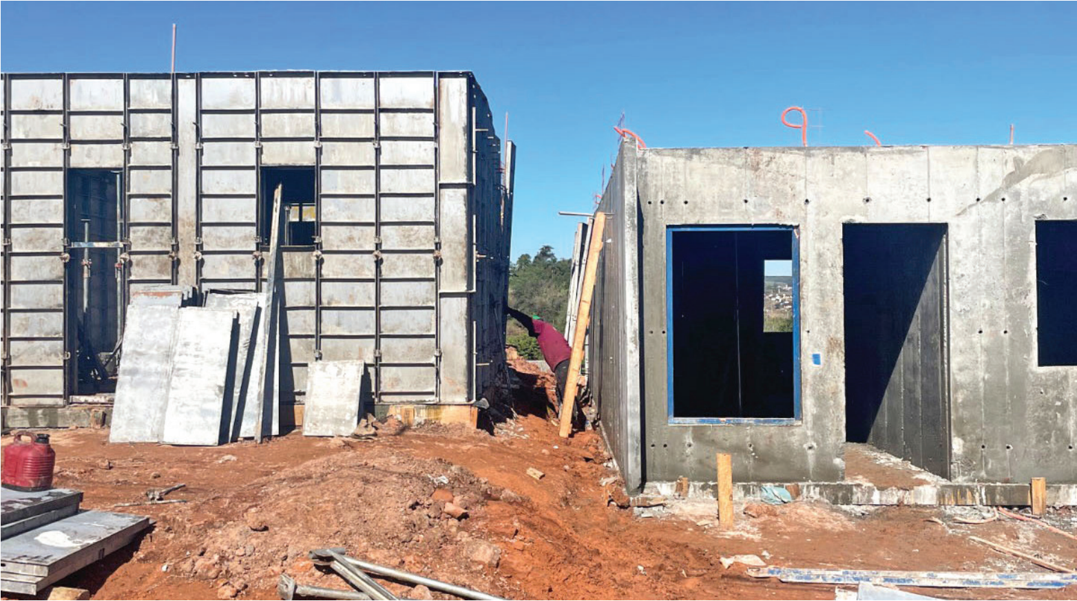
Obras têm prazo de execução de 18 meses. Objetivo é atender as famílias de Lajeado atingidas pelas cheias de 2023 e 2024
