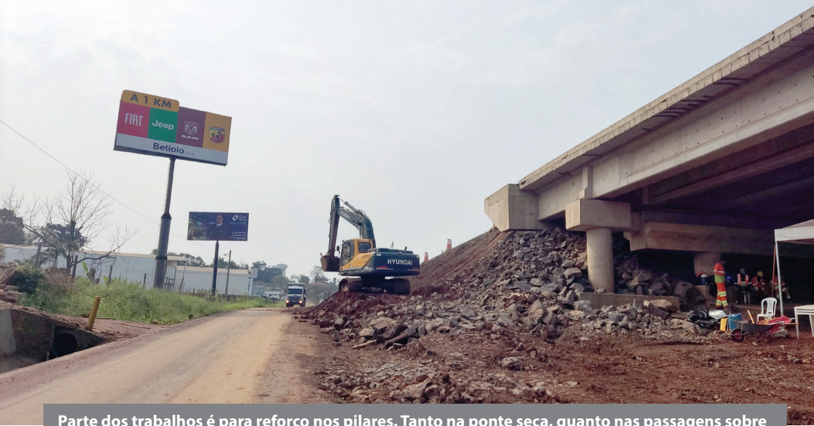
Parte dos trabalhos é para reforço nos pilares. Tanto na ponte seca, quanto nas passagens sobre o Rio Taquari e no Arroio Boa Vista, entre as duas maiores cidades da região
