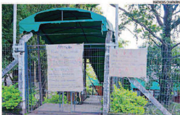
Posto de Saúde do São Cristóvão foi interditado e serviços, transferidos
