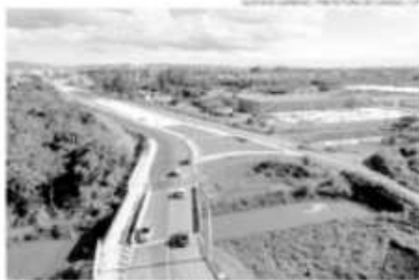
Avanço das obras tem execução da ponte e finalização do trecho 7
