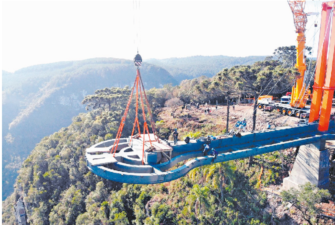
Primeira parte da montagem da plataforma, que terá 35 metros de comprimento, foi concluída ontem
