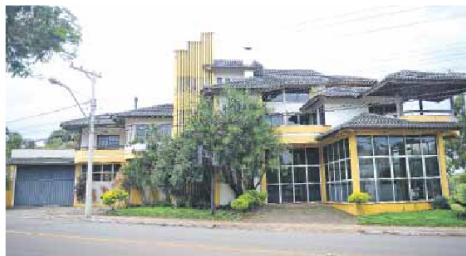
DRACO: delegacia ficará no primeiro andar de prédio localizado na Avenida dos 15, no Bairro Florestal
