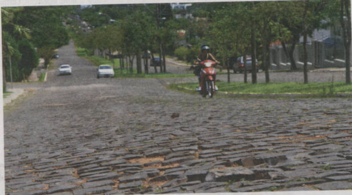
Sosur pretende pavimentar 900 metros entre a BR-389 e a esquina com a rua Antônio de Souza Neto
