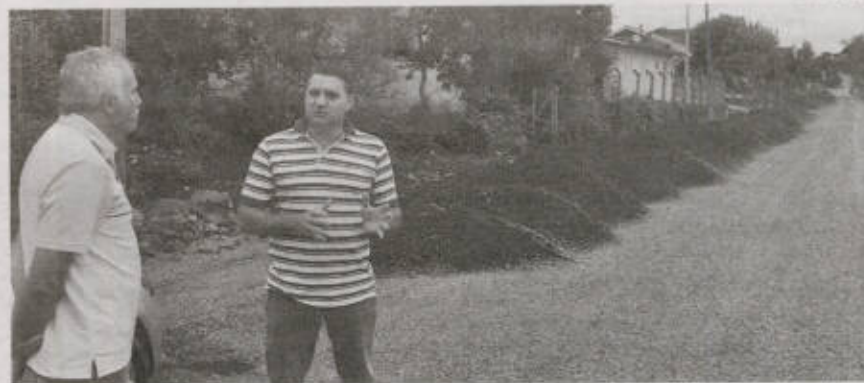
Schmidt e Cerutti visitaram obras de pavimentação asfáltica em duas ruas do Bairro Igrejinha
