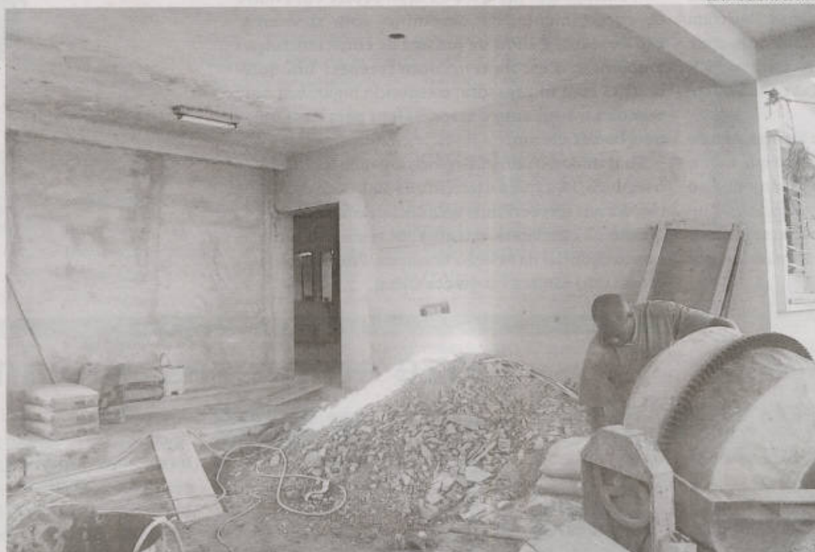
Serviços entram na fase de acabamentos
