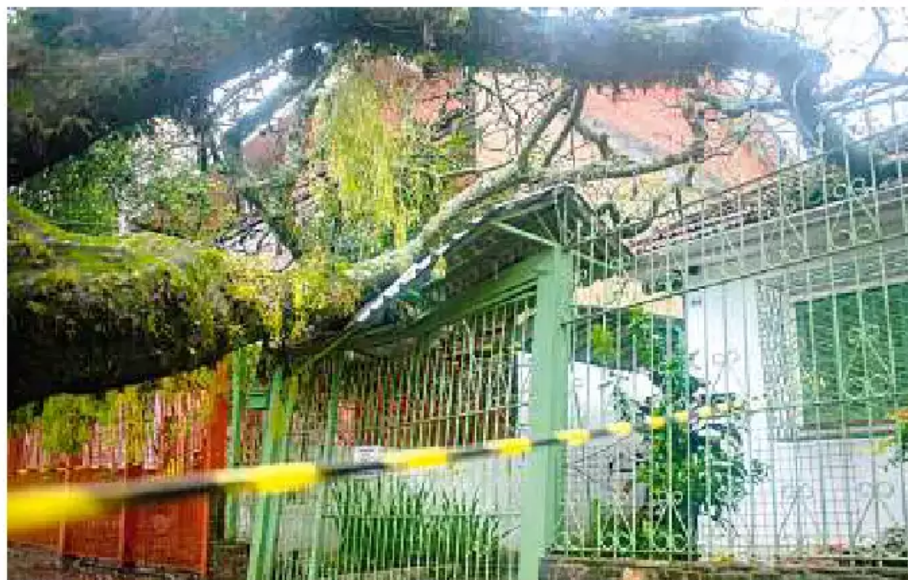
Queda ocorreu sobre muro e moradia da rua Arabutan
