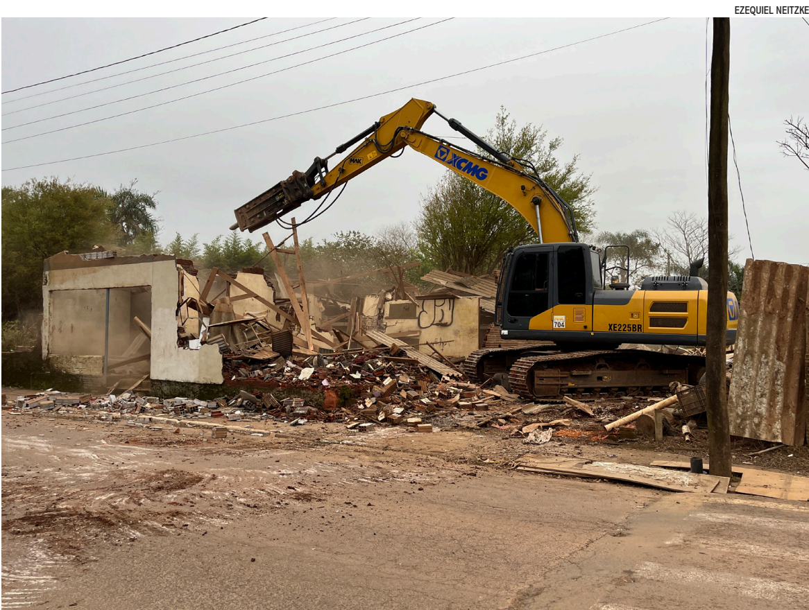
Demolições de residências nas áreas alagáveis prosseguiu nessa semana, na rua Francisco Oscar Karnal, no Centro
