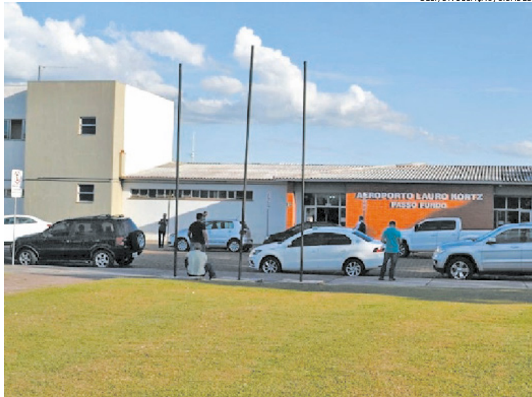
Investimento deve chegar a R$ 43,2 milhões para reforma do terminal
