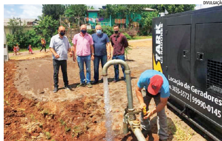
Conforme a Corsan, desde a instalação de poço artesiano, bairro não tem mais problemas de abastecimento de água
