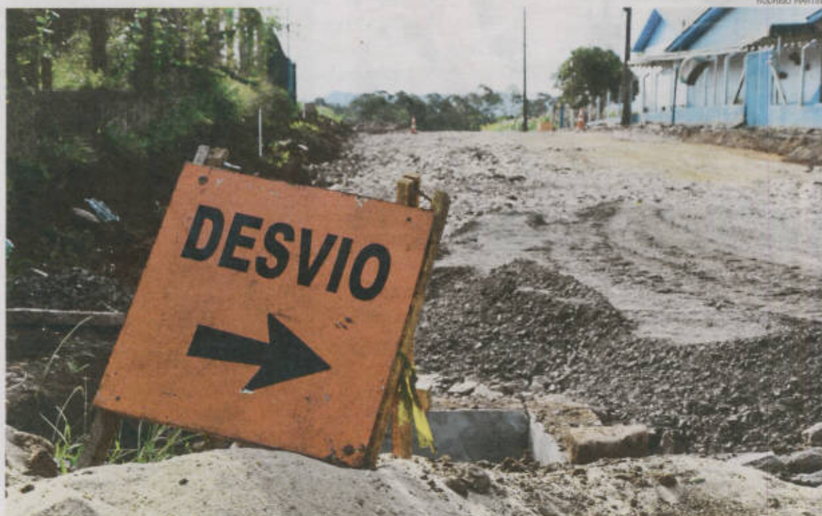
Obras de R$ 20,5 milhões estão em ritmo lento devido à falta de repasses. MPF avalia suposto sobrepreço no contrato
