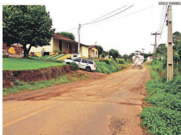
Trecho deve custar cerca de R$ 3,6 milhões. Estado custeará 70% da obra
