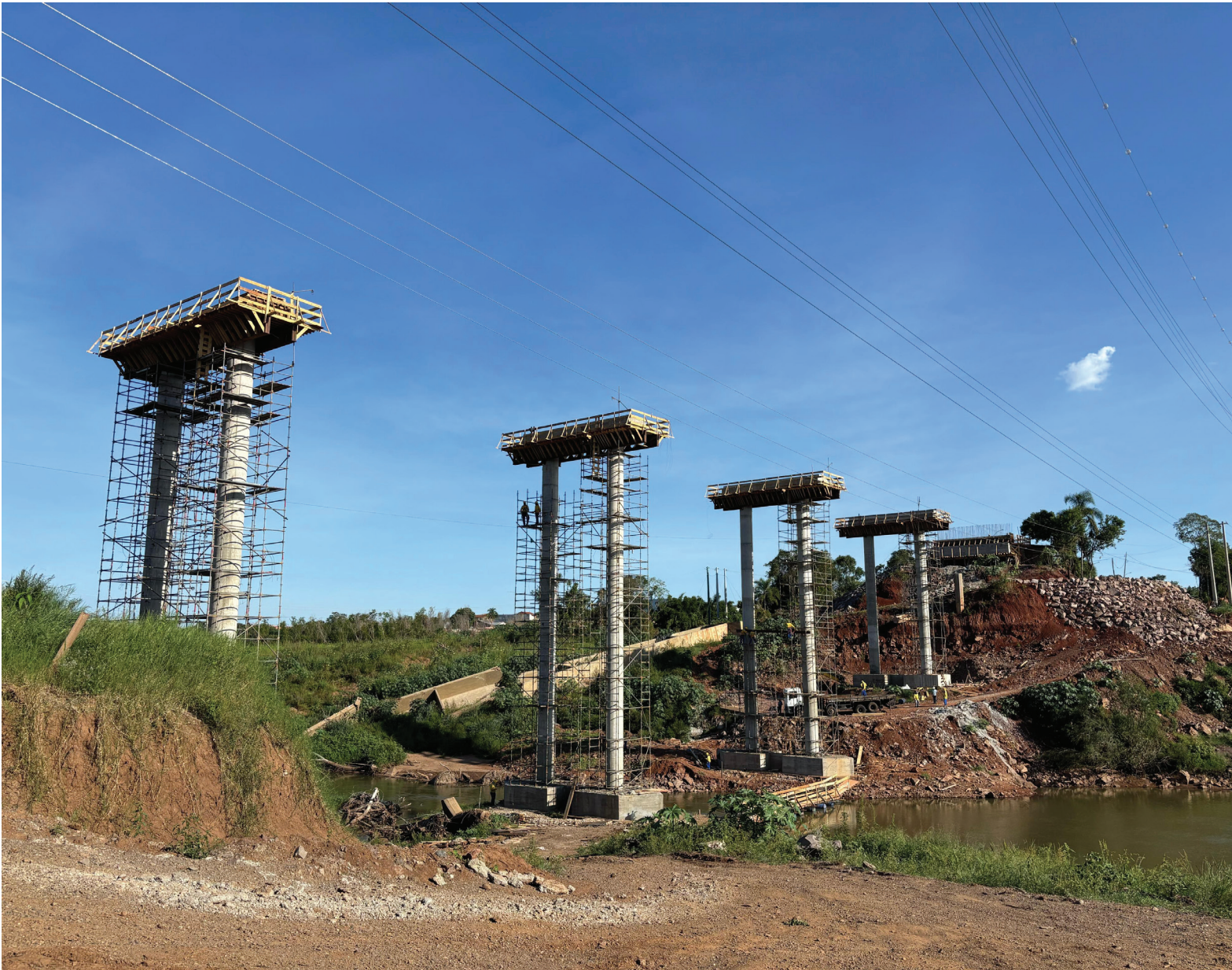
As 24 vigas serão içadas de oito em oito, o que permitirá colocação das lajes na sequência
