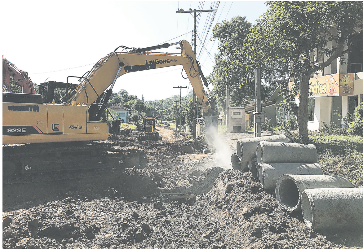
Rompedor hidráulico é utilizado para quebra de laje na Avenida Rio Grande do Norte
