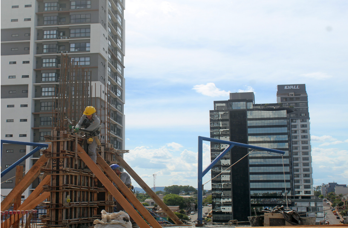
Número de alvarás liberados na construção civil é o maior na cidade desde o início da série histórica, em 2018
