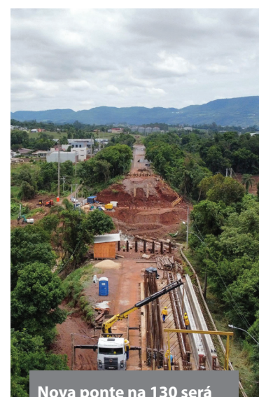
Nova ponte na 130 será erguida cinco metros acima do nível da anterior
