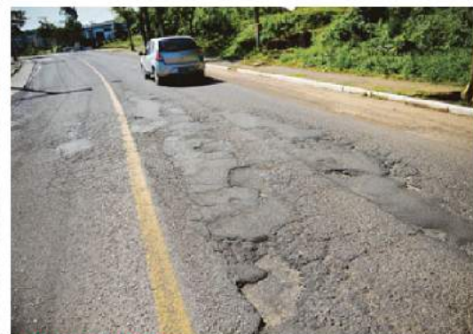
MOVIMENTAÇÃO: a via é importante para trabalhadores
