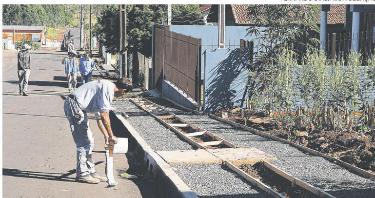
Obras seguem na Rua Cecília Koche Brackmann
