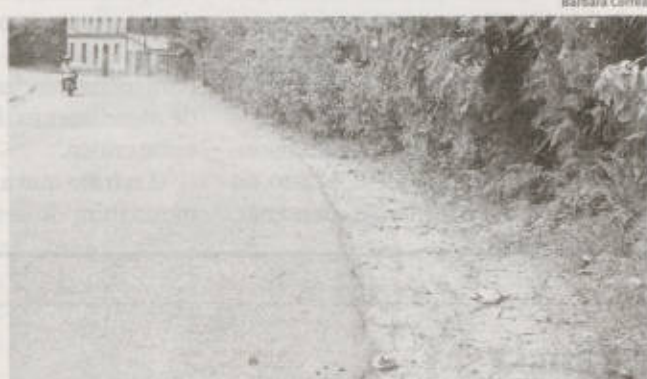
MATO: galhos e árvores já cobriram o acostamento na Rua Rubens Feldens, em Cruzeiro do Sul
