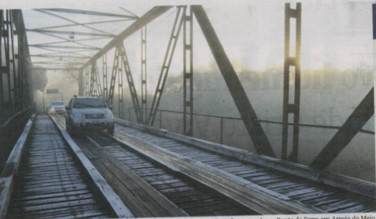
Onda de frio sobre a região mudou a paisagem. Na manhã de ontem, gelo se formou sobre a Ponte de Ferro em Arroio do Meio
