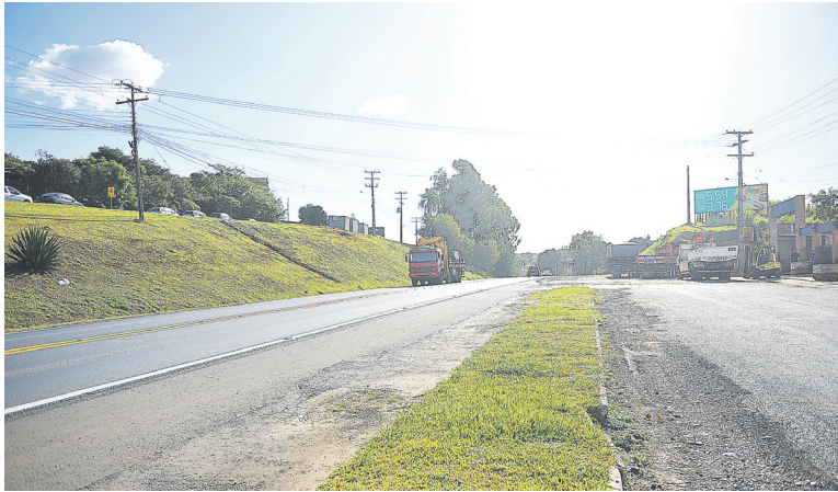
Obra será executada próximo a residências e comércios
