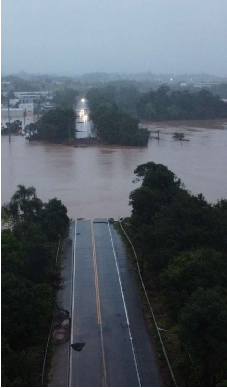
Força da enchente do Rio Forqueta derrubou ponte na ERS-130, entre Lajeado e Arroio do Meio. Soluções alternativas foram adotadas até a inauguração da nova estrutura, em abril de 2025
