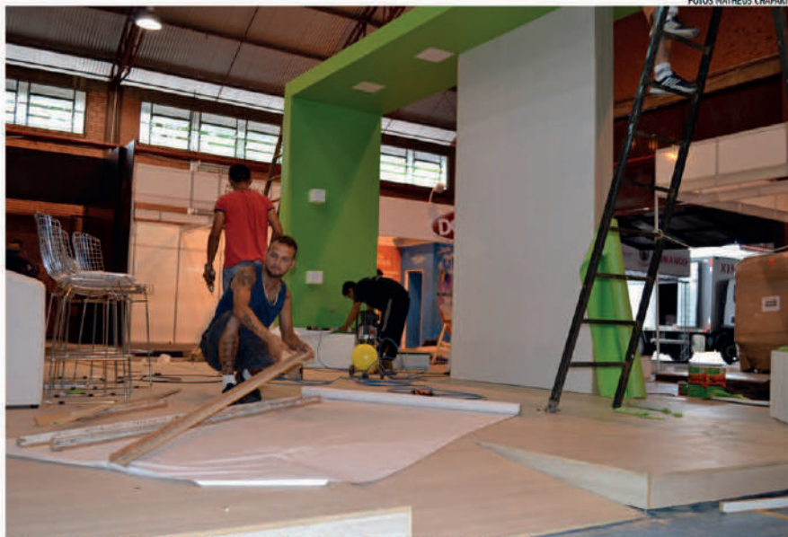
Feira começa amanhã. Cerca de mil trabalhadores integram equipes de montagem, vigilância e limpeza do evento
