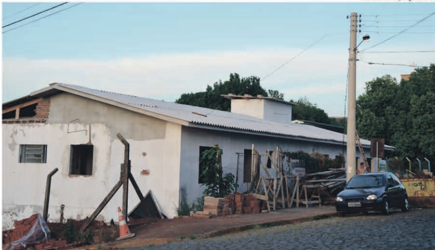
Obra iniciada em 2016 não tem previsão para ser finalizada. Em dois meses, deve ser contratada nova empresa
