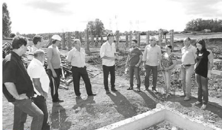
ROTEIRO: grupo conheceu construções que estão em andamento
