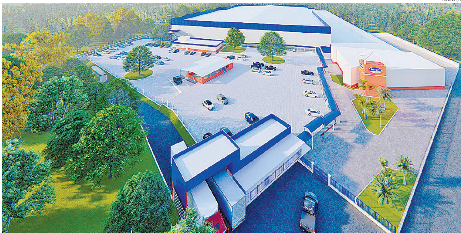
Obra para ampliar Centro de Distribuição em Lajeado está em andamento. Projeto prevê quadruplicar espaço de armazenagem que abastece 23 unidades
