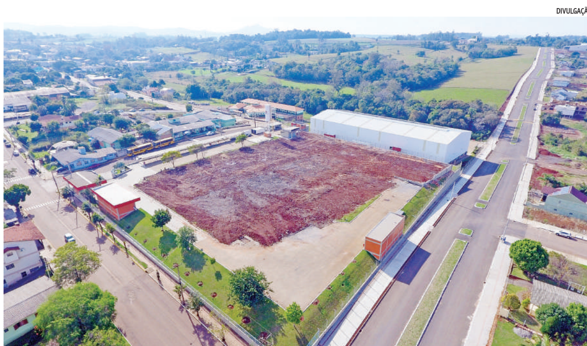
Máquinas já iniciaram a limpeza do terreno que foi atingido por um incêndio em março de 2020
