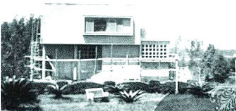
Construído na década de 50, é uma referência da arquitetura da época
