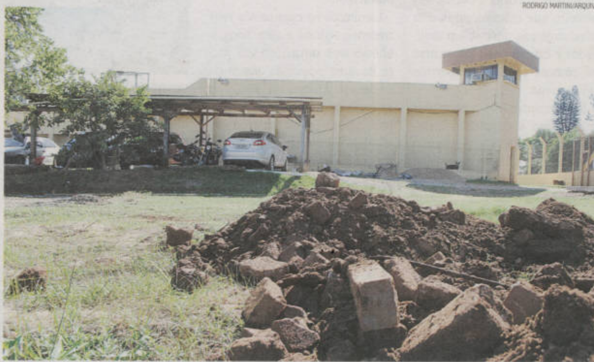
Compra de material passará por processo licitatório. Construção será feita pela mão de obra prisional
