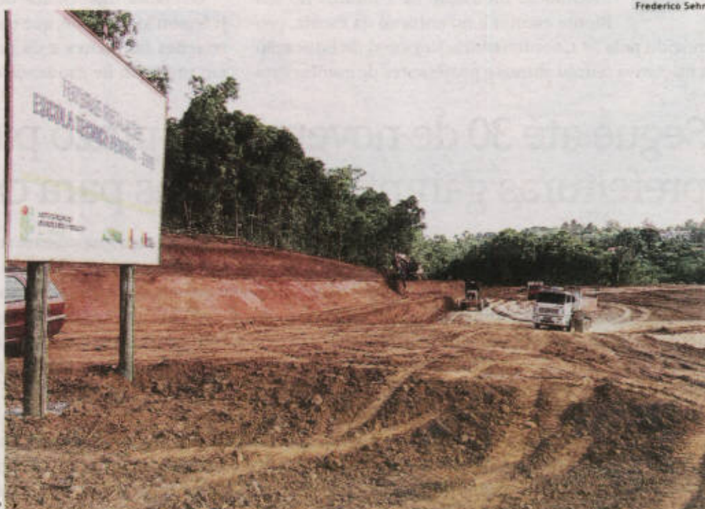
O serviço de limpeza e terraplanagem do solo deve ser concluído até o final de novembro
