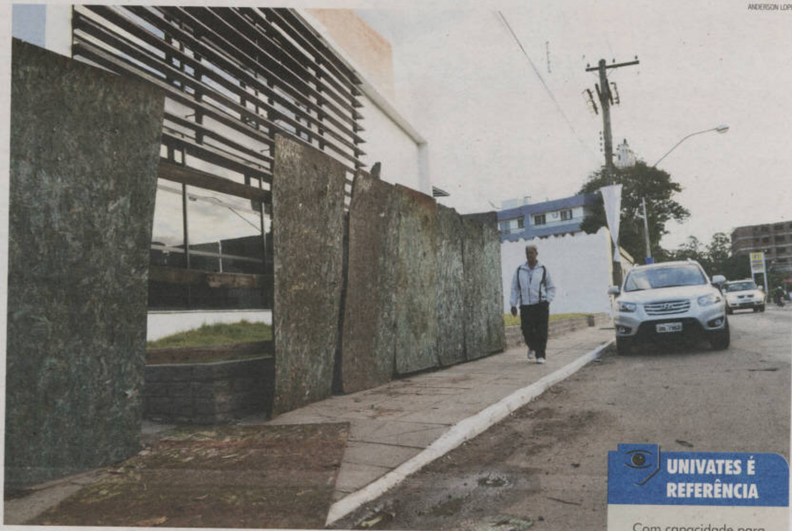
Obra começou em 2009 e tinha previsão de ser concluída três anos depois. Investimento já passou de R$ 3 milhões
