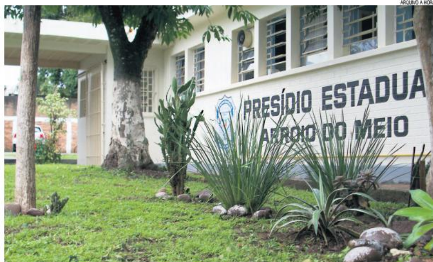
Projeto prevê a construção de um alojamento feminino com banheiro e uma sala para reuniões e apresentações
