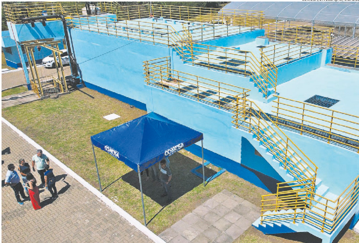
ETE estará ligada em um sistema que ainda está em construção e será responsável por tratar 50% do esgoto
