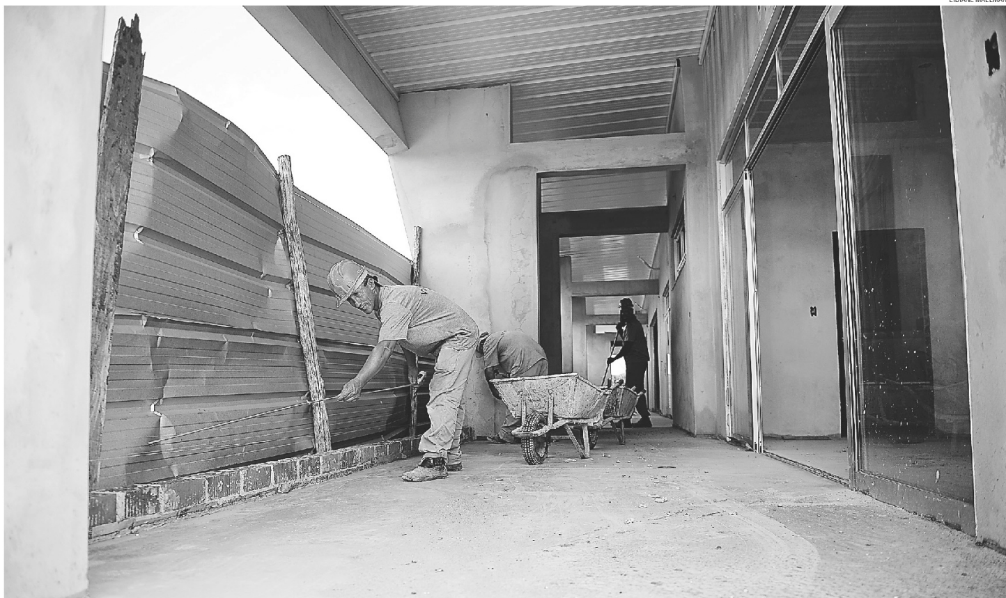
Obras na Emei do Santo Antônio estão em andamento e devem ser concluídas em fevereiro
