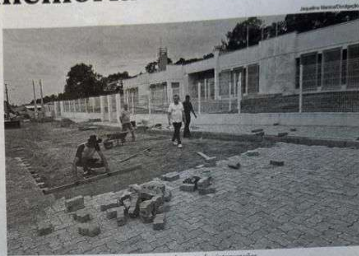
O prefeito Sidnei Eckert acompanhou de perto o andamento das intervenções
