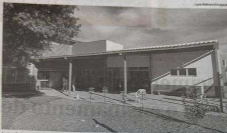
Lajeado inaugura novo prédio e reforma do Projeto Vida Santo Antônio
