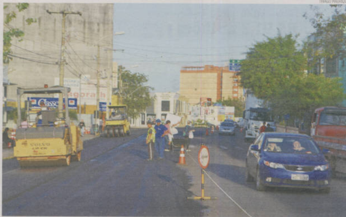
Condutores são orientados a reduzir a velocidade e buscar rotas alternativas. Previsão é concluir o trecho em 30 dias
