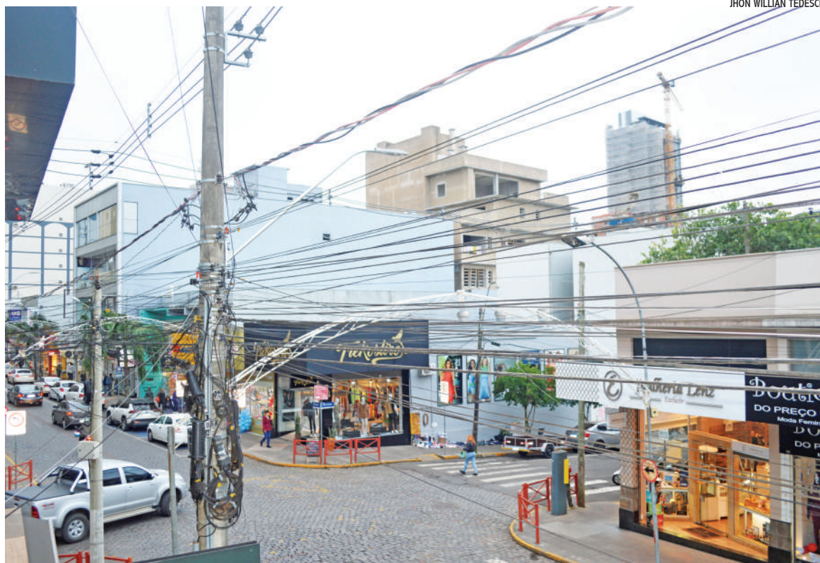
Lei de 2019 obriga os prestadores de serviço de energia, internet e telefonia a alinhar e retirar os fios inutilizados
