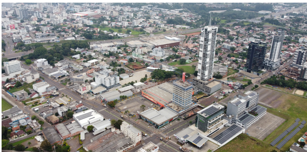
Trabalhos possibilitam continuidade de projeto para melhorar mobilidade urbana no São Cristóvão
