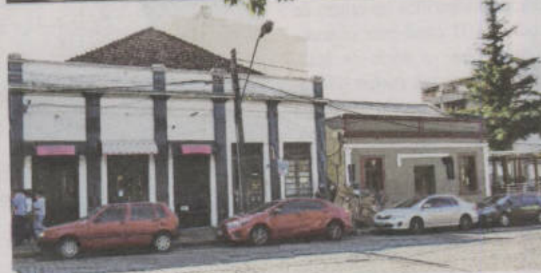
Fotografias mostram o antes e o depois em prédios históricos do centro
