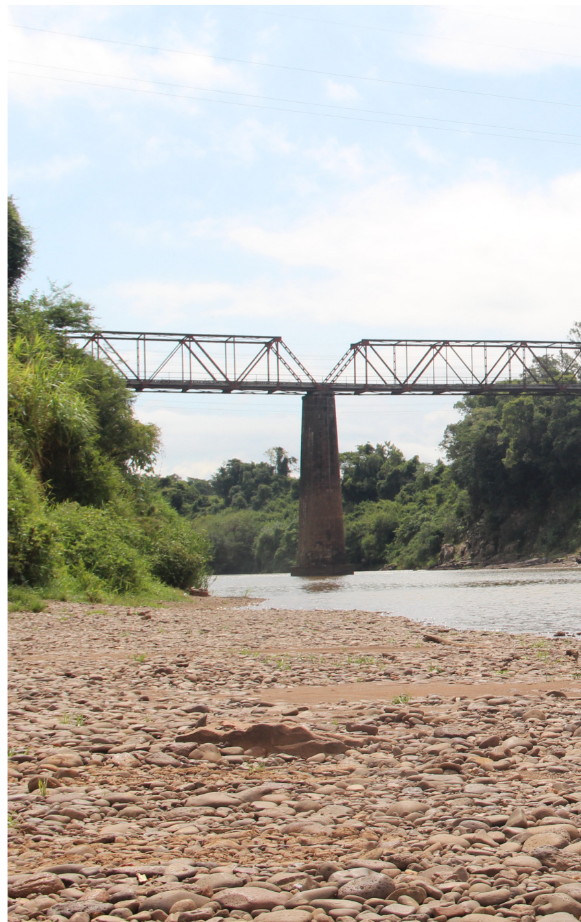
Uma das opções dos dois governos é construir a nova ponte ao lado da histórica estrutura metálica sobre o Rio Forqueta
