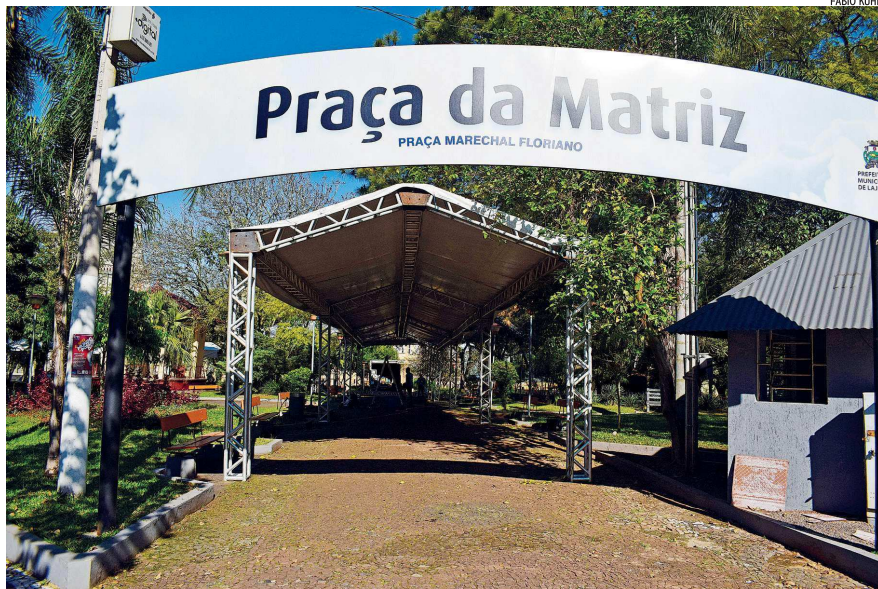
Montagem da estrutura deve ser concluída hoje à tarde. Mais de 40 obras serão lançadas no evento
