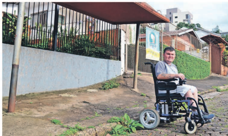
Além da ausência de ônibus com elevadores, cadeirantes enfrentam falta de rampas nas paradas
