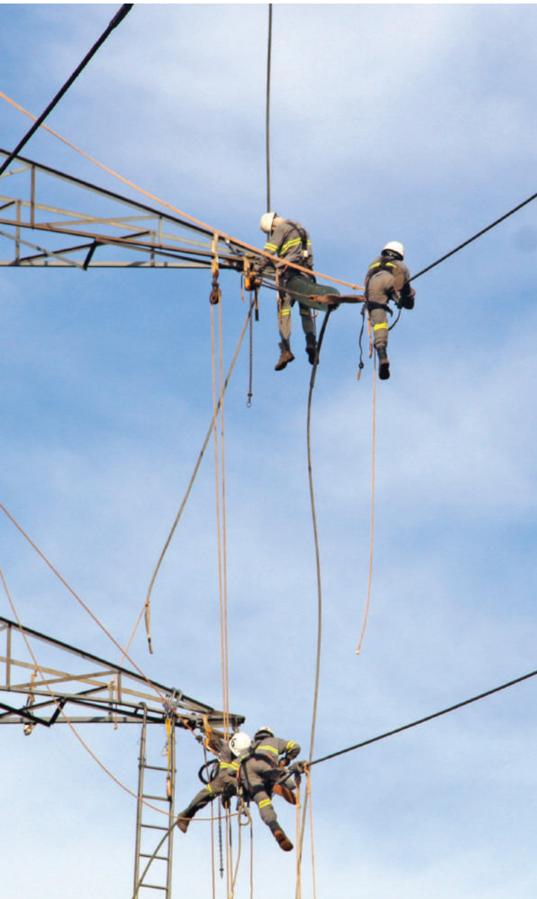
redes para restabelecer a energia elétrica na região
