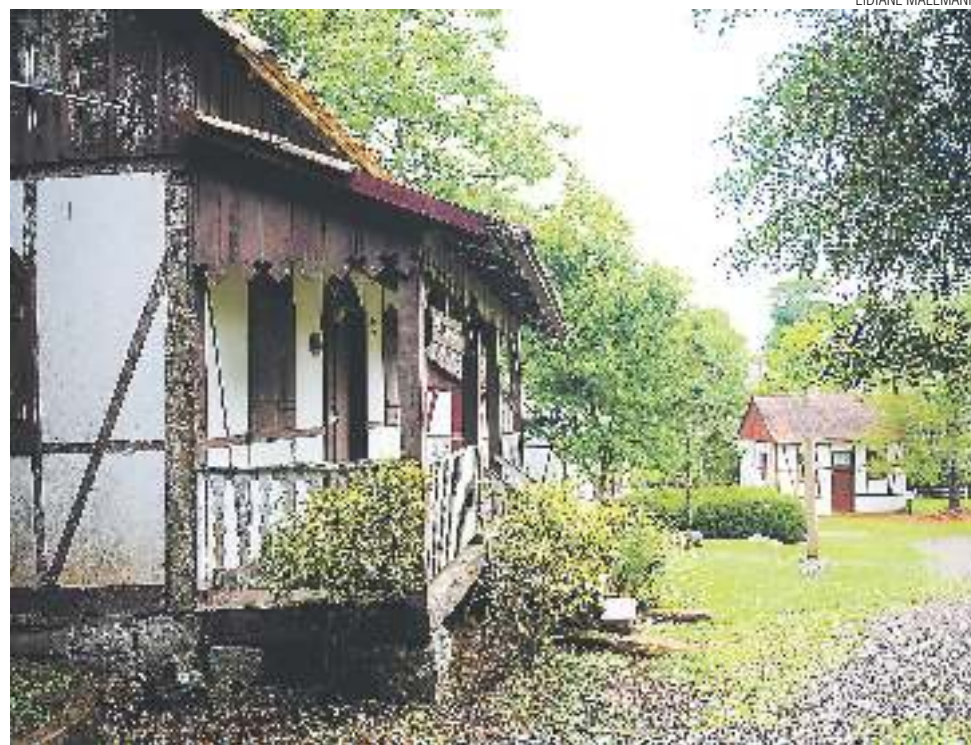
Edificações foram desmontadas no interior e remontadas no parque
