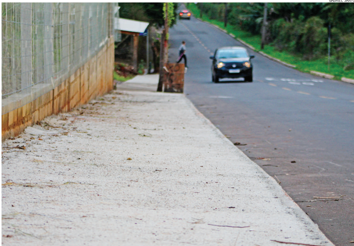
Calçada na rua Rio Grande do Sul, no bairro Santo André, foi uma das construídas por meio do programa
