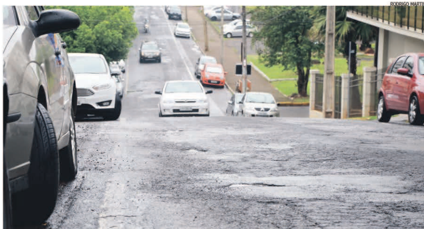
Trecho de quase 600 metros de extensão será recapeado. Previsão é de iniciar a obra em abril
