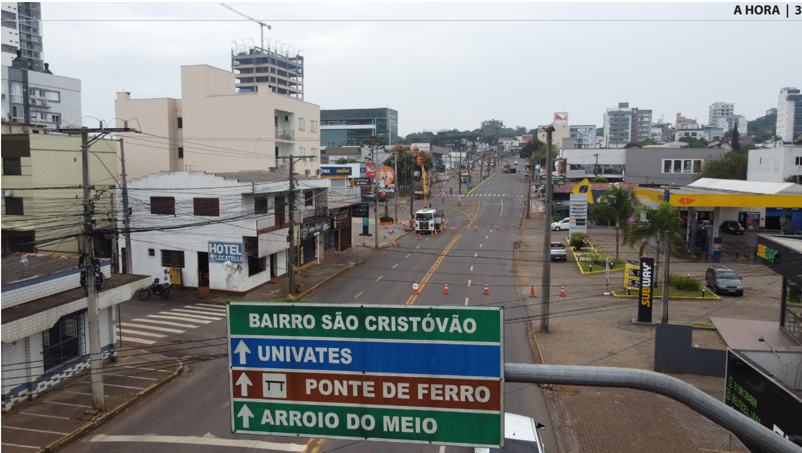
Na semana passada, retirada de redes de energia abriu caminho para continuidade do projeto
